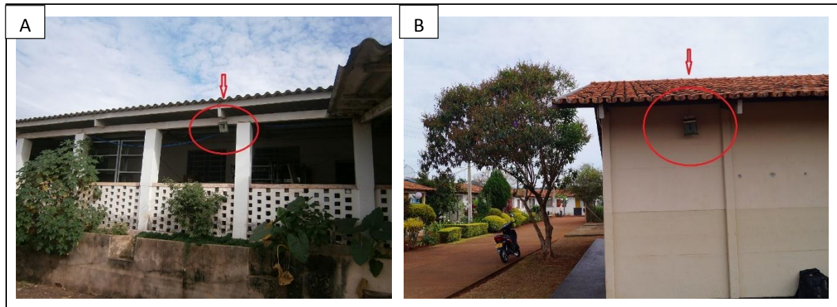
Figura 03 – Aparelhos instalados, A) P5 e B) P3 Autor: ROCHA. J. R. R. (2014)
