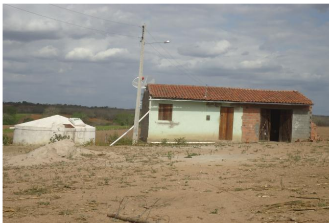
Figura 03 – Pão de Açúcar (AL): Cisterna de Placa Fonte: CARVALHO (2013)
